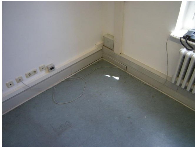
Abbildung 10: Telefonkabel verläuft über den Boden des Rechenzentrums (eigene Darstellung, 2017).
