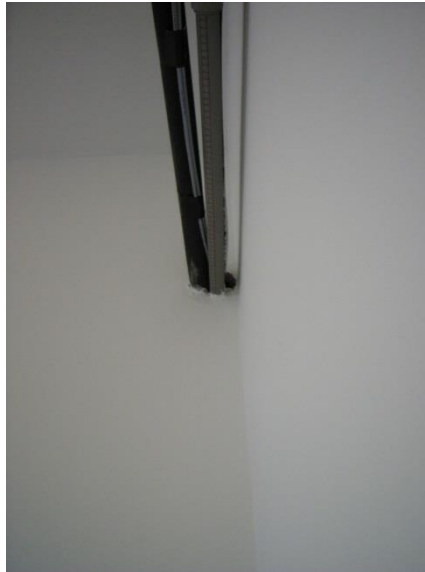
Abbildung 7: Wanddurchbruch vom Rechenzentrum ins anliegende Büro (eigene Darstellung, 2017).
